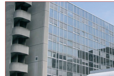
● | Pharmacie Centrale en bâtiment modulaire.
